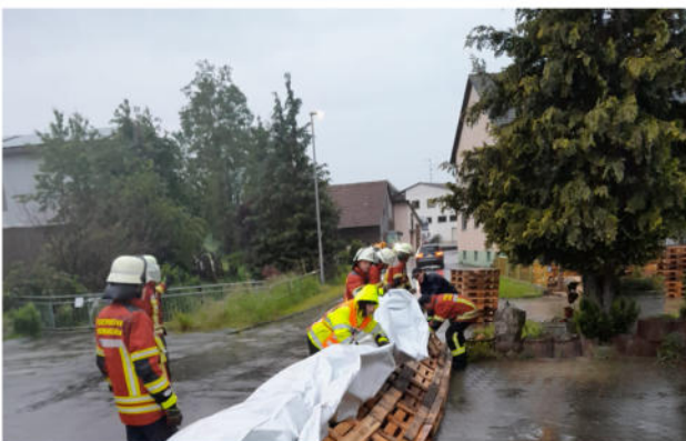
Hochwasseralarm: routiniert wurden die Barrieren aufgebaut
