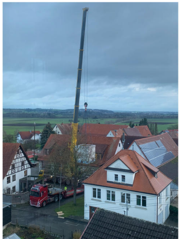
Das Aufstellen des Breitband-Hauptverteilers am Rathaus
